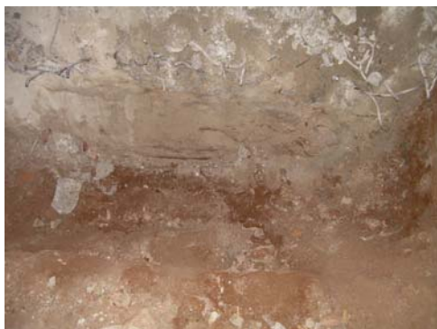
primer pla de la trava arribats a la cota d'obra
