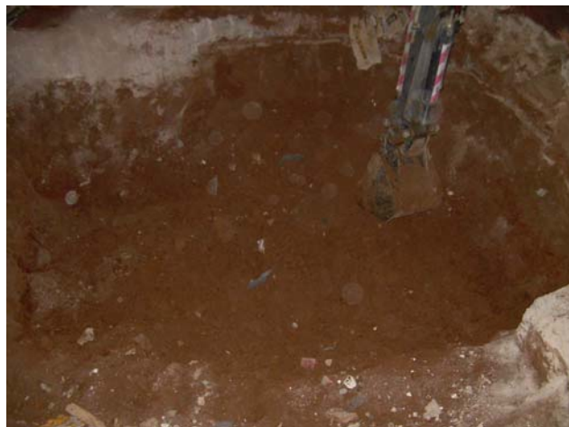
Procés d'excavació de la cala 2 amb una minicarregadora
