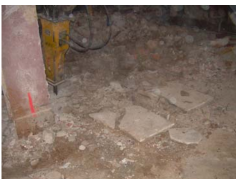
Martell hidràulic picant el terra de la cala 3
